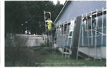
Sett opp utstyr til neste høyde opp mot stillaset.
