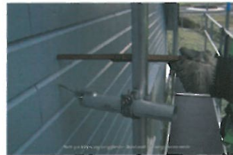
Sett på klips og veggfeste. Avstand fra vegg som nede.
