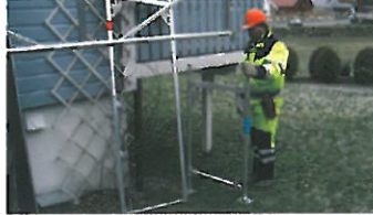
Bruk en 1 meters ramme i bunn om høydeforskjellen i terrenget blir for stor for kun stillbein.
