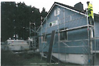
Montér rammer og rekkverk.
