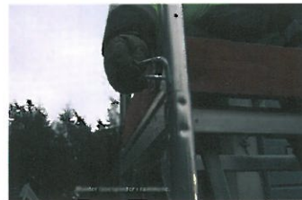
Montér låsesplinter i rammene.
