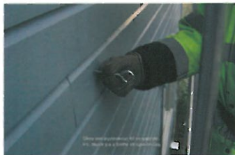
Skru inn øyenskrue til veggfeste. PS! Husk på å treffe et spikerslag.
